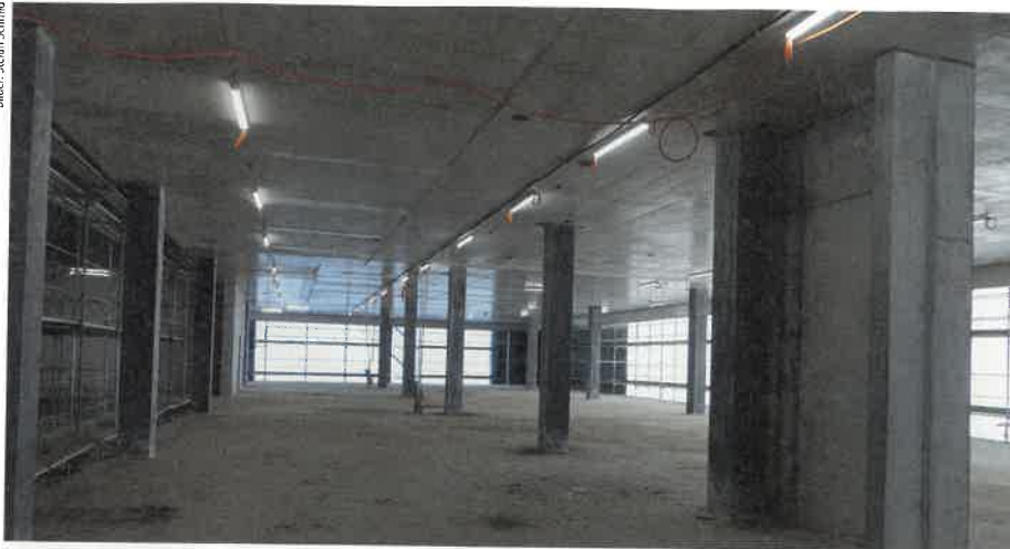
Das Gebäude umfasst 3500 Räume. Anhand von Raumtypen, die durch Funktionalitäten bestimmt sind, konnte die Bauherrschaft die Bestellung klarer formulieren. (Bild: Bereich der Operationssäle.)
